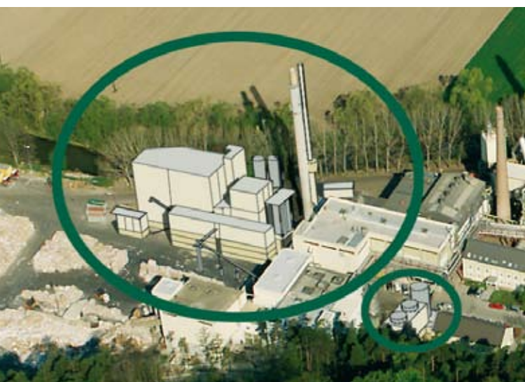
Die Markierung zeigt den Standort der geplanten Anlage am Gelände der W. Hamburger GmbH.
